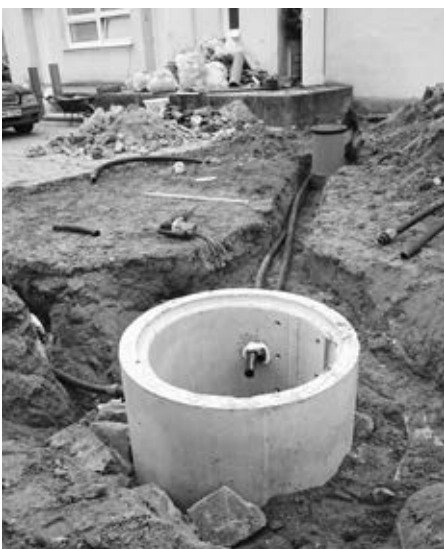
Dokončili sme odkanalizovanie MŠ jej napojením na verejnú kanalizačnú sieť.
