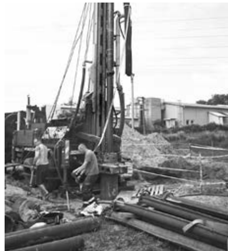
Vyvrátili sme novú studňu, ktorú chceme začleniť do súčasného systému verejného vodovodu.
