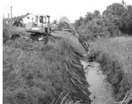
Čistenie odvodňovacích kanálov sa vykonáva priebežne a teda aj tento rok.
